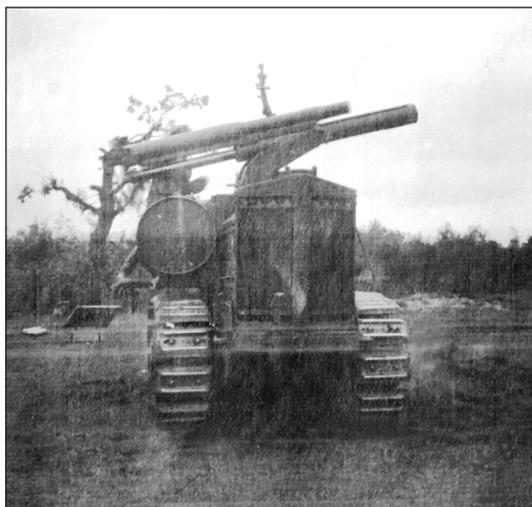
**Рис. 3. Самоходная установка 76-мм пушки обр. 1902 г. на тракторе «Коммунар 3-90». Вид установки при стрельбе на борт в момент полного отката**
