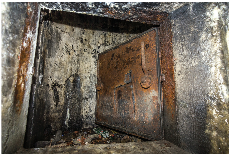
Ил. 3. Гродненская крепость. Форт IV. Входной люк в броневой наблюдательный пост системы ГИУ. Современное фото
