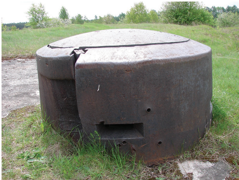
Ил. 1. Гродненская крепость. Форт III. Купол броневый наблюдательного поста системы ГИУ на стрелковом бруствере. Современное фото
