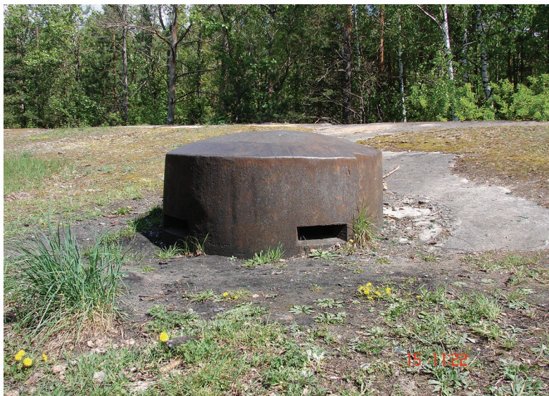
Ил. 4. Гродненская крепость. Форт IV. Купол броневго наблюдательного поста системы ГИУ на стрелковом бруствере. Современное фото
