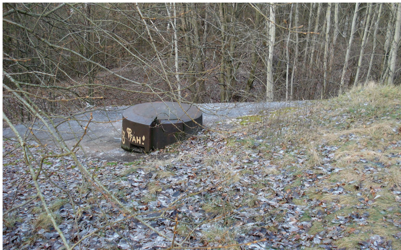
Ил. 5. Гродненская крепость. Форт V. Купол броневго наблюдательного поста системы ГИУ на стрелковом бруствере. Современное фото
