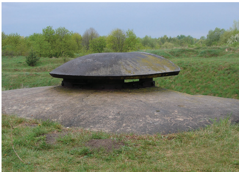
Ил. 7. Брест-Литовская крепость. Форт V. Колпак наблюдательного поста системы Аренса на казематированном траверсе. Современное фото
