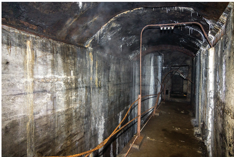
Ил. 2. Гродненская крепость. Форт IV. Подбрустверная галерея с выходом в броневый наблюдательный пост системы ГИУ. Современное фото
