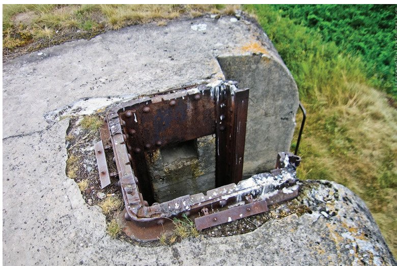
Ил. 8. Брест-Литовская крепость. Форт V. Срезанный наблюдательный пост системы Аренса на казематированном траверсе. Современное фото
