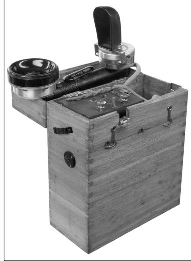
Рис. 2. Военно-полевой телефонный аппарат петроградского завода акционерного общества русских электротехнических заводов «Сименс и Гальске». 1916 г.
