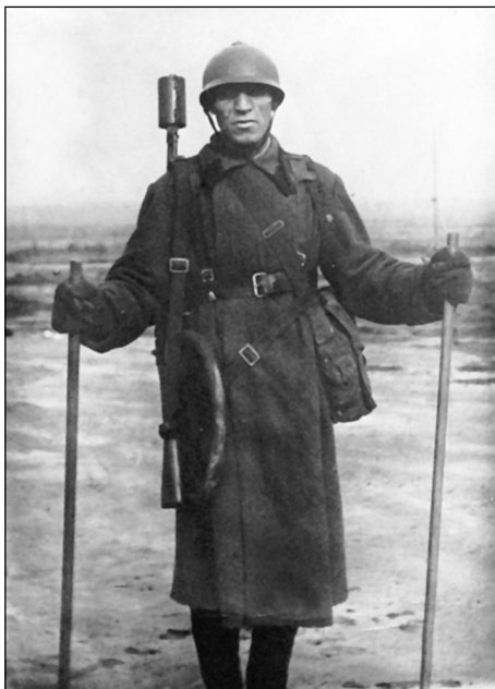
Рис. 1. Огнемётчик на лыжах. 1941 год При движении на лыжах ружье огнемёта типа РОКС находилось в руке или в положении «На ремень». В последнем случае ружье огнемёта закреплялось на бойце при помощи вспомогательного ружейного ремня. Для этого петля вспомогательного ружейного ремня прикреплялась верхним тренчиком вместе с ружейным ремнем. После чего ружье бралось в положение «На ремень», вспомогательный ружейный ремень пропускался за спиной поверх резервуара и под левой рукой обводился спереди туловища и пристегивался к ружью нижним тренчиком
