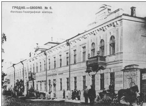
Гродно. Здание почтово-телеграфной конторы. Фото ок. 1901 г.
