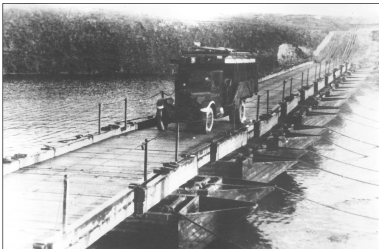
Рис. 1. Наплавной мост из парка ДМП-41
