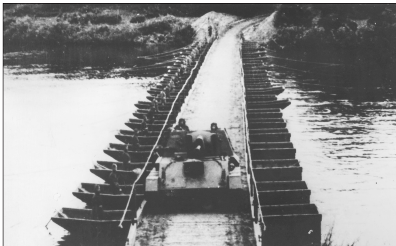
Рис. 4. Наплавной мост из парка ДЛП
