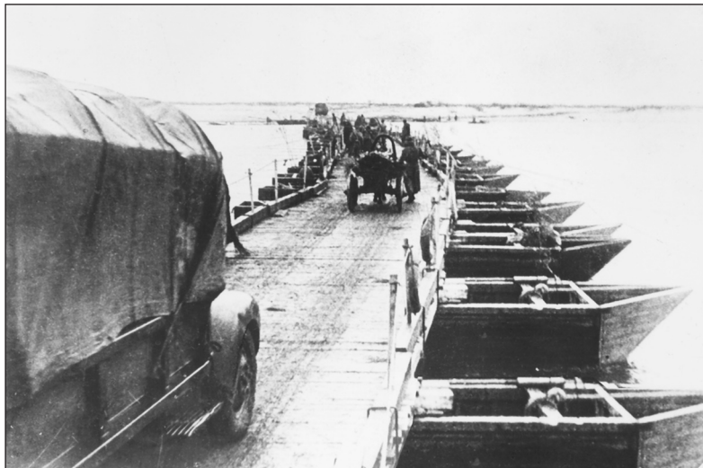
Рис. 2. Наплавной мост из парка ДМП-42
